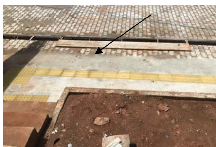
Figura 17 - Tipo de finalização entre concreto e bloco intertravado não será permitida
